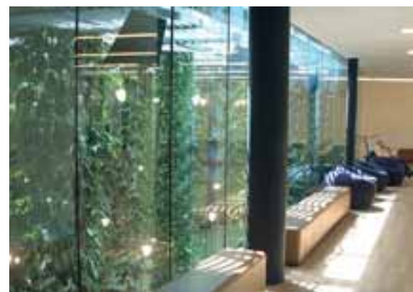
F30-Verglasung mit vertikalen Silikonfugen F30 glazing with vertical silicone joints
