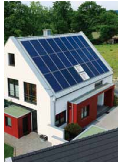
Eksempel på heltagsmontage med integreret tagvindue
